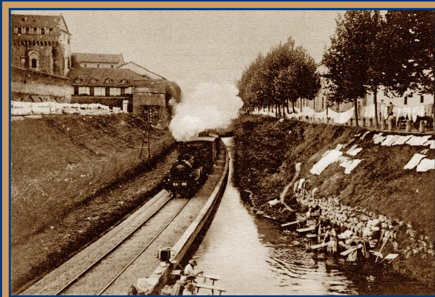
Anni 30 - la fossa della linea ferroviaria Pavia-Cremona; a destra è visibile Viale Argonne mentre sulla sinistra si stagliano le mura spagnole del lato settentrionale del Castello. Il corso d'acqua è lo "scaricatore" del Naviglio ed immancabile la presenza delle lavandaie, che a Pavia ritroviamo ovunque vi sia la presenza dell'acqua, intente a lavare ed asciugare i panni. Al centro dell'immagine la locomotiva a vapore diretta a Cremona.
