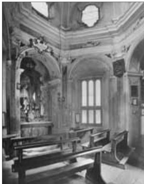
L'interno della cappella settecentesca a pianta ottagonale del Ponte Vecchio distrutto dai bombardamenti del 1944.
