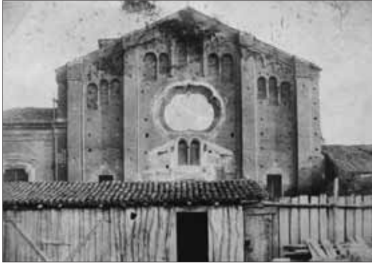
Fine Ottocento - La facciata della chiesa di Borgo Ticino prima dei restauri. La fotografia è stata scattata dove un tempo sorgeva il cimitero del rione.
